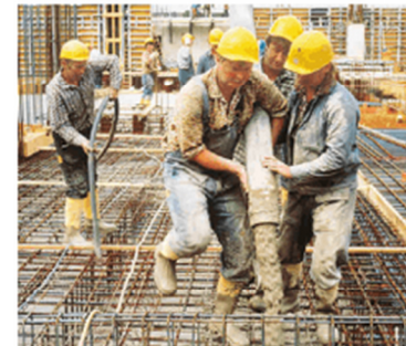
3 Die Stahlbewehrung wird mit Beton ausgegossen.
