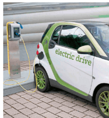
3 Ladestation für Elektroautos
