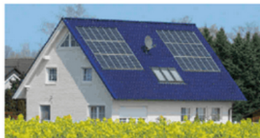
2 Dach mit Solarmodulen
