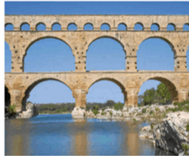
3 Die Pont du Gard bei Nîmes ist über 2000 Jahre alt und eine der kühnsten und schönsten Steinbogenbrücken der Römer.
