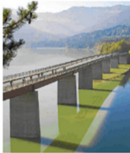
2 Balkenbrücke aus Spannbeton
