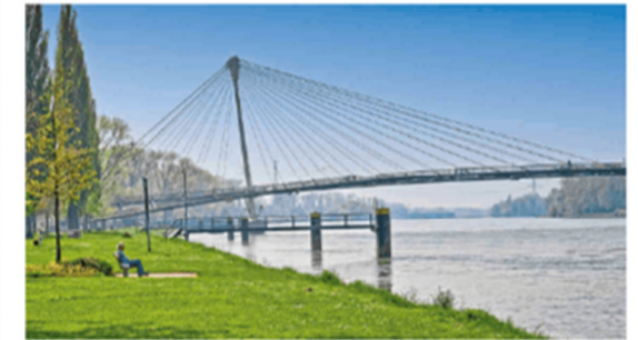
5 Die Passerelle zwischen Kehl und Straßburg ist eine Schrägseilbrücke.
